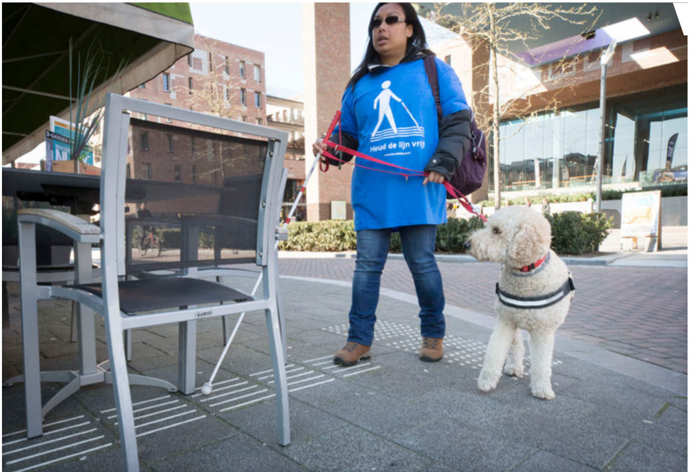
▲ Jirada Mulder loopt met haar blindengeleidehond en stok over het trottoir bij het station. De geleidelijn loopt zo dicht bij de gevel dat hij onder de terrasstoelen verdwijnt. © Pix4Profs/Joyce van Belkom
